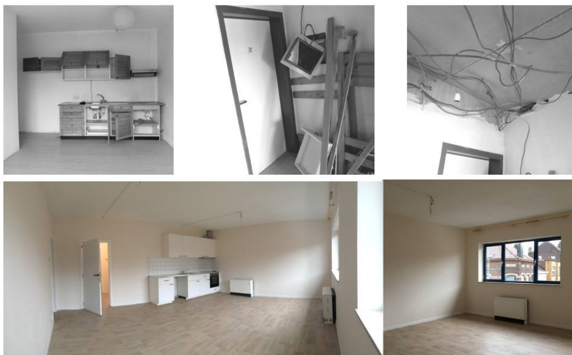
251 Chaussée de Mons, avant - après
