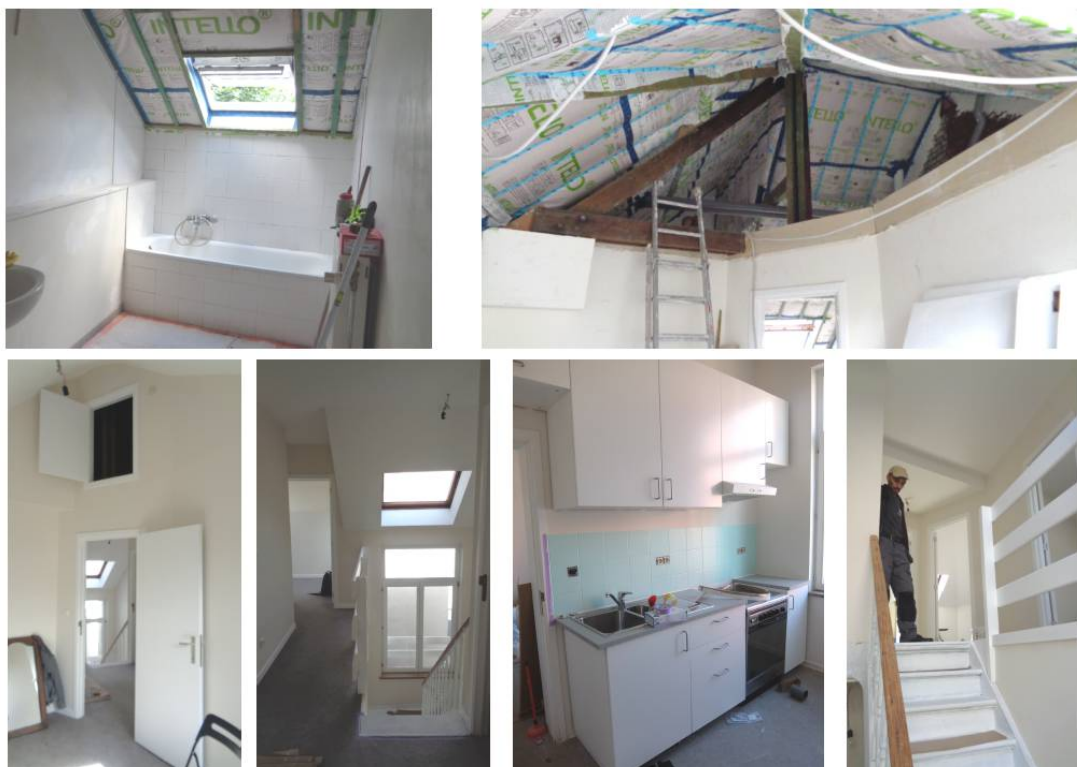
Le 12 Place Lemmens : situation après travaux.
