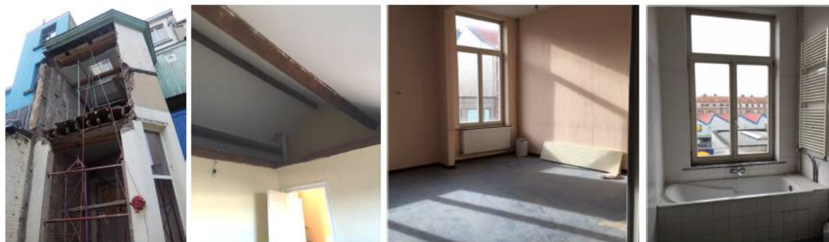
façade arrière en cours de travaux et situation existante intérieure.
