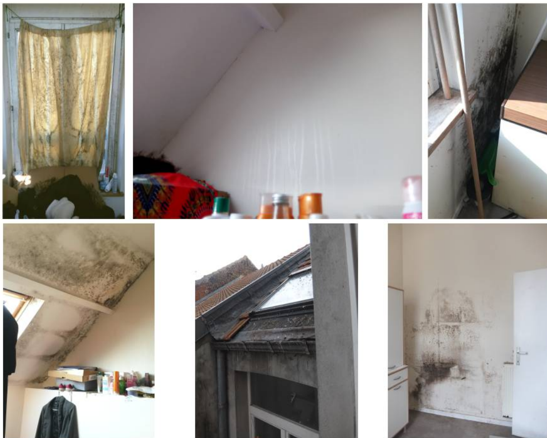
Le 12 Place Lemmens : situation avant travaux.
