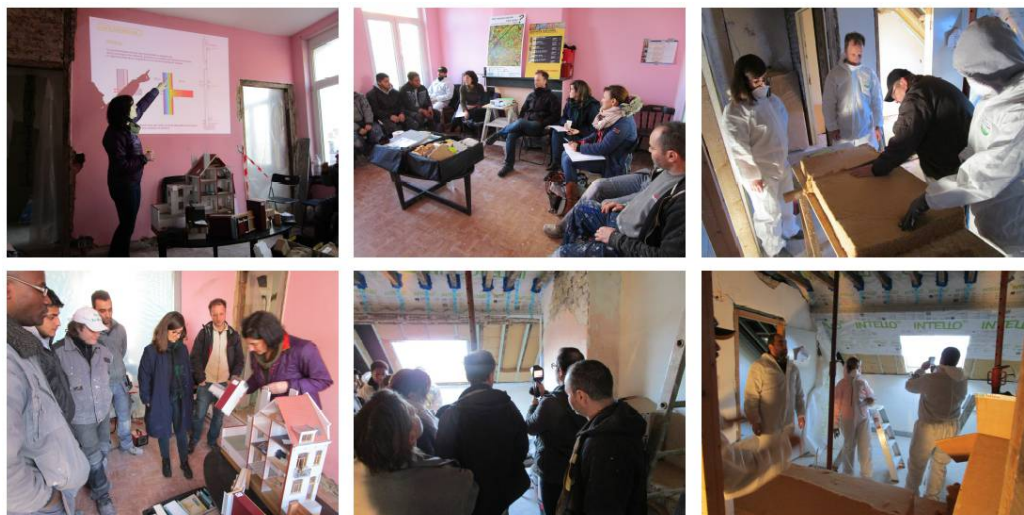
Initiation au chantier durable - formation extérieure 2 « Isolation naturelle » : thermographie, présentation d'outils, ateliers pratique et théorique. Plus de photos sur les formations se trouvent dans les annexes 8 et 9 de ce rapport (les annexes sont téléchargeables sur notre site web).
