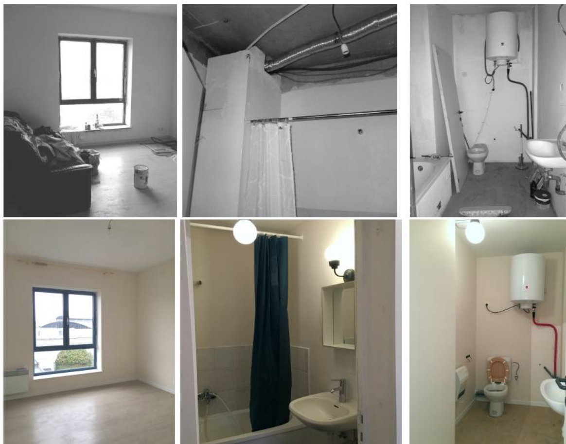
251 Chaussée de Mons, avant – après
