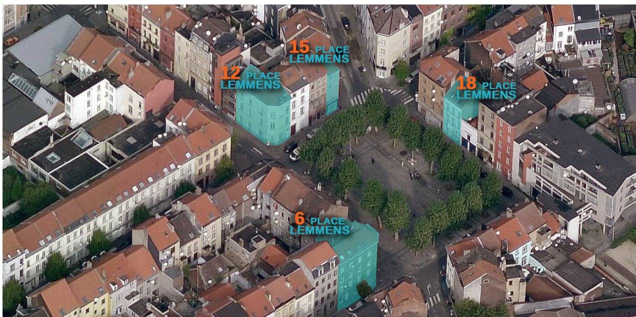
Quatre logements à la place Lemmens dont la toiture a été rénové
