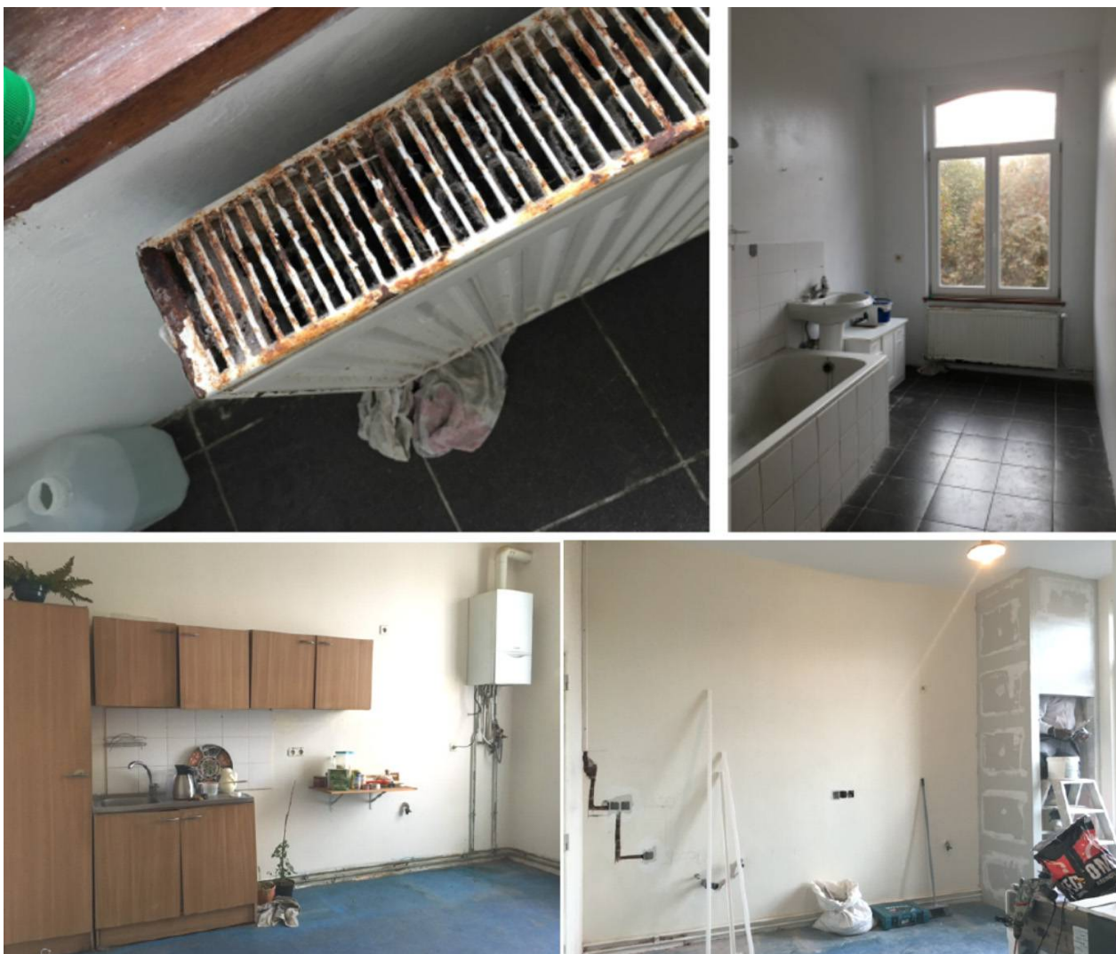
20 Lemmens ; photos du haut : situation avant travaux de la salle de bain ; Photos du bas : la cuisine, avant – et pendant le chantier.
